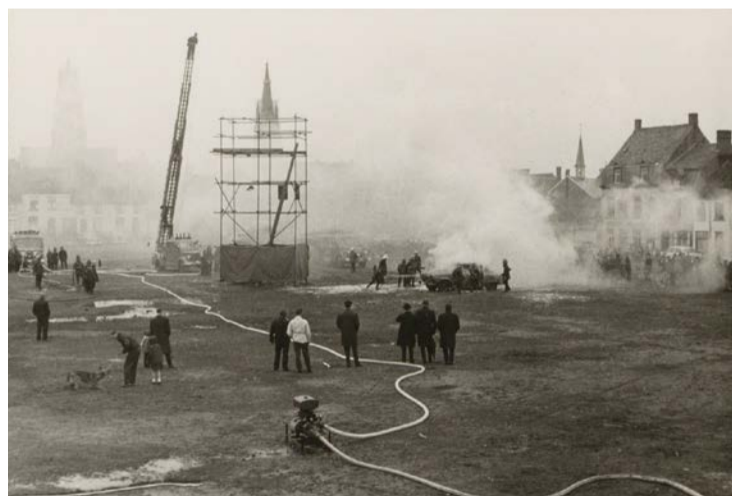
► Brandweeroefening (1958) — Onder grote belangstelling houdt de Brugse brandweer een oefening op het latere Beursplein. De huizen rechts op de foto situeren zich in de Hauwerstraat. (Bron: Beeldbank Brugge)
